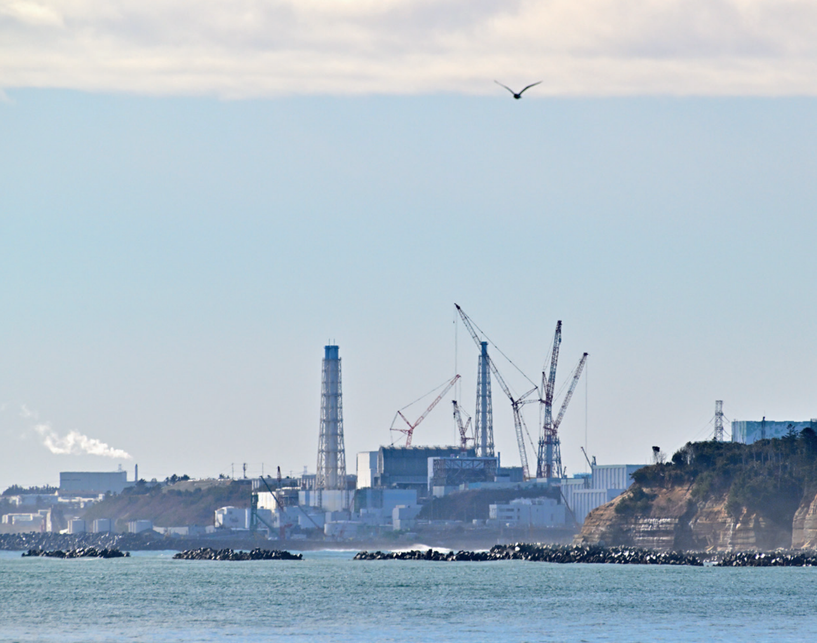
Sicht auf das Atomkraftwerk Fukushima Daiichi vom Hafen Ukedo, Japan.
