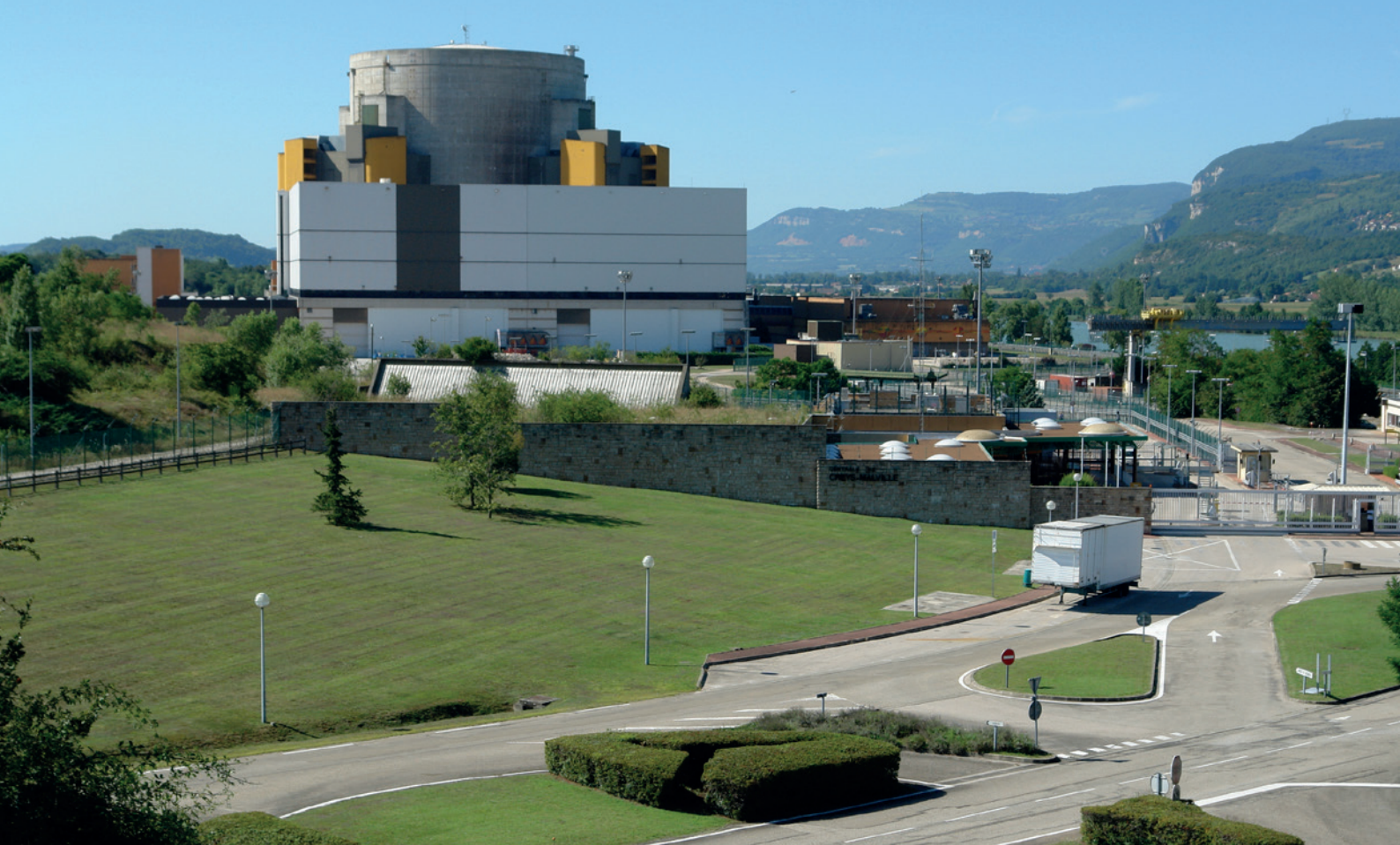
Réacteur surgénérateur désaffecté «Superphénix», Creys-Malville, France
